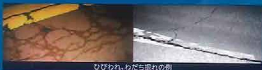
ひびわれ、わだちぬれの例
