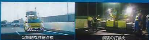
定期的な詳細点検
