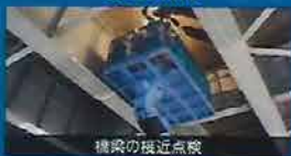
橋梁の接近点検
