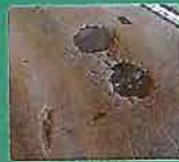
路面補修工事
