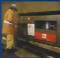
泡消火栓点検
