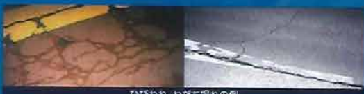
ひびわれ、わだちぬれの例
