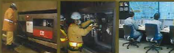
泡消火栓点検
